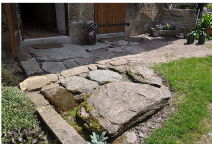
Abb. 35: Natursteinstufen und Wegebelag (Foto: Dr. T. Büttner)
