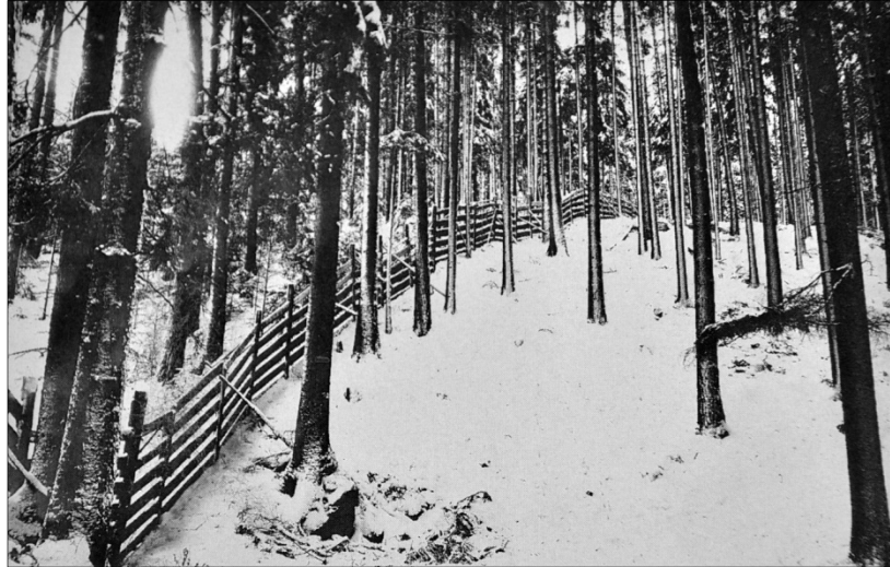
Abb. 31: Ehemaliges Wildgatter als Stangenhordenkonstruktion im heutigen Staatlichen Forst (Quelle und Datum: unbekannt)
