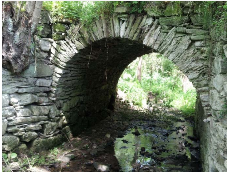
Abb. 53: Natursteinbrücke aus Zechstein-Kalk (Foto: H.-H. Meyer)
