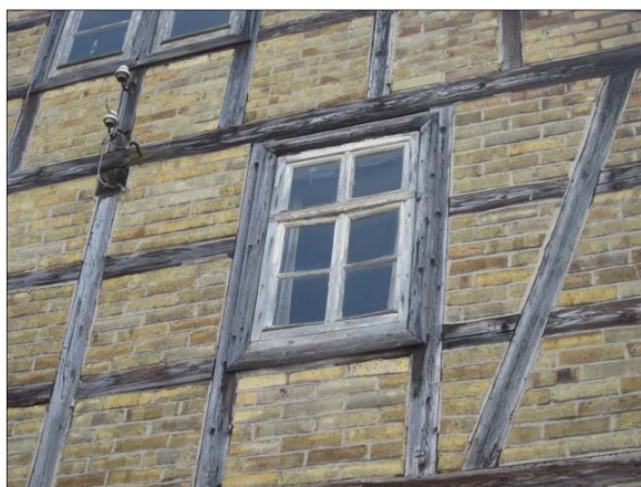
Abb.32: Gefache mit Ziegelsteinen gemauert (Foto: S. Kreis)
