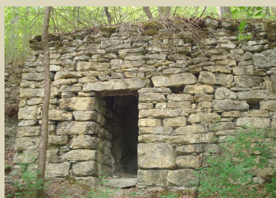
Ein Weinbergshaus im Jenaer Metztal. Wände und Dach bestehen aus Jenaer Muschelkalkstein.
